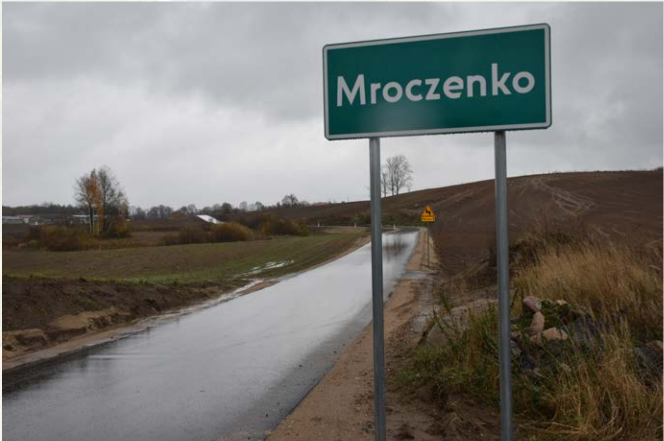
Zmodernizowana droga Mroczenko - granica gminy.
