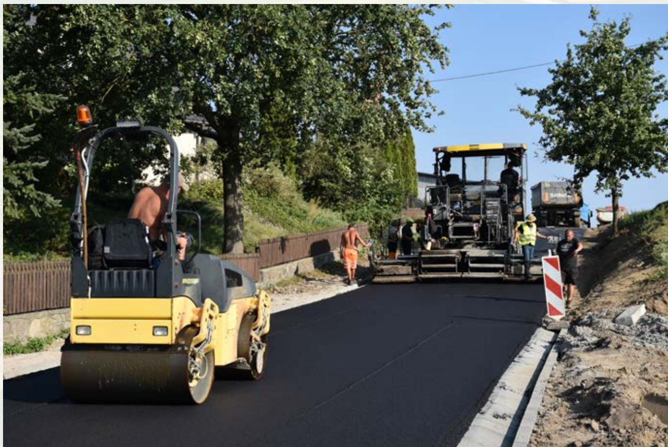
Modernizacja drogi Linowiec - Montowo.
